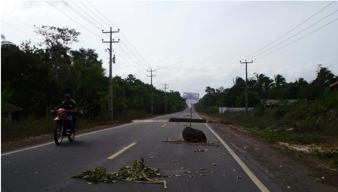
Figura 21: Obstrução de uma faixa da MA 014 para construção de quebra-molas no início num povoado de Palmerândia (km 157).
