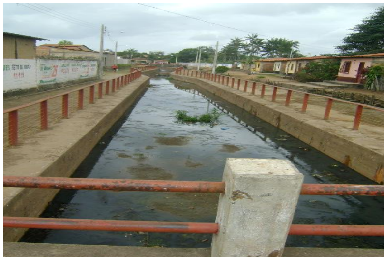
Figura 13: Efluentes sendo conduzidos para a calha do rio Pericumã no município de Pinheiro pela vala do Gabião.
