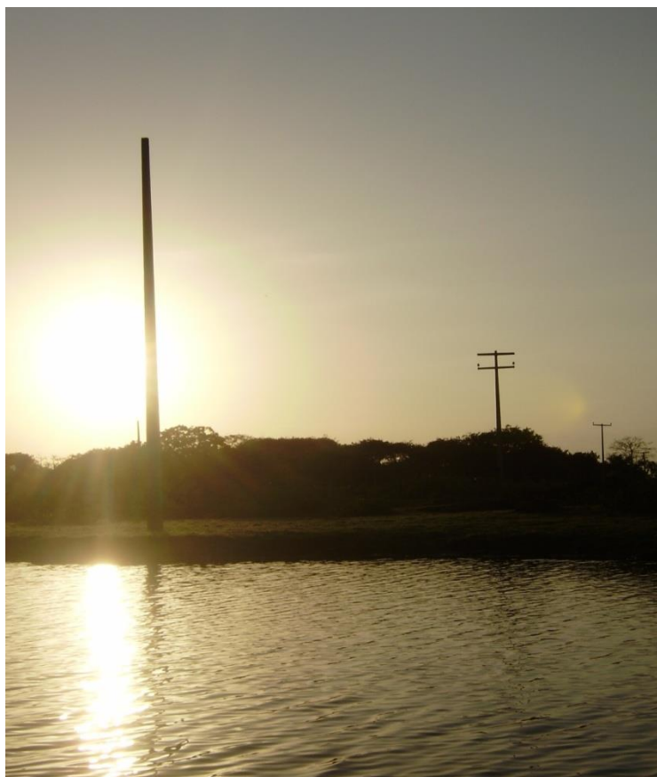
Figura 05: Rede elétrica implantada pelo Programa Luz Para Todos em 2009 em APP no município de Pinheiro.
